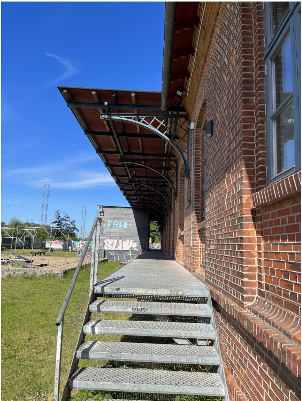
Tagudhæng langs den sydlige facade på Ungdommens Hus.
