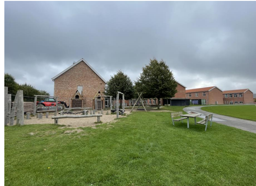
Erritsø Fællesskole Krogsager renovering af gavl med genbrugstegl
