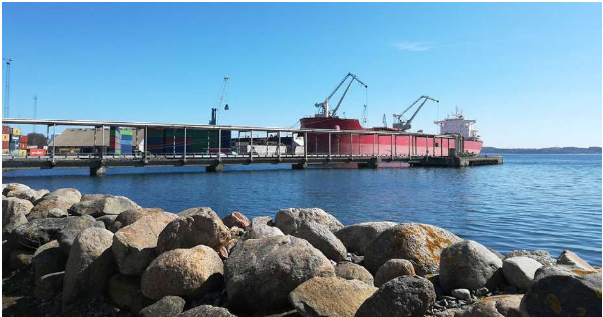
Den nuværende bro pier ved kaj 23
