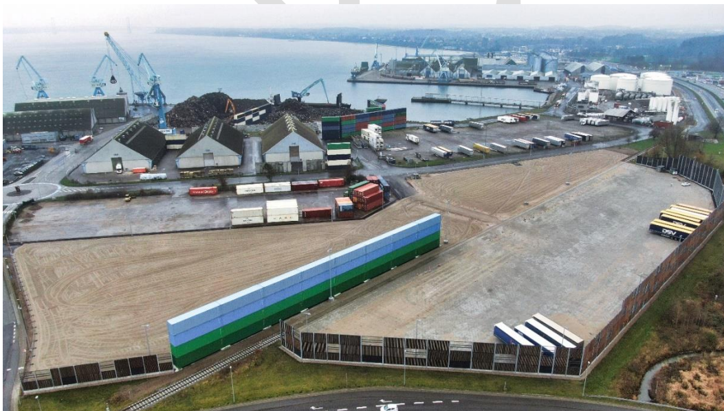
Figur 3-7 i miljøkonsekvensrapporten: RO/RO trailerplads med støjskærme etableret i 2021
