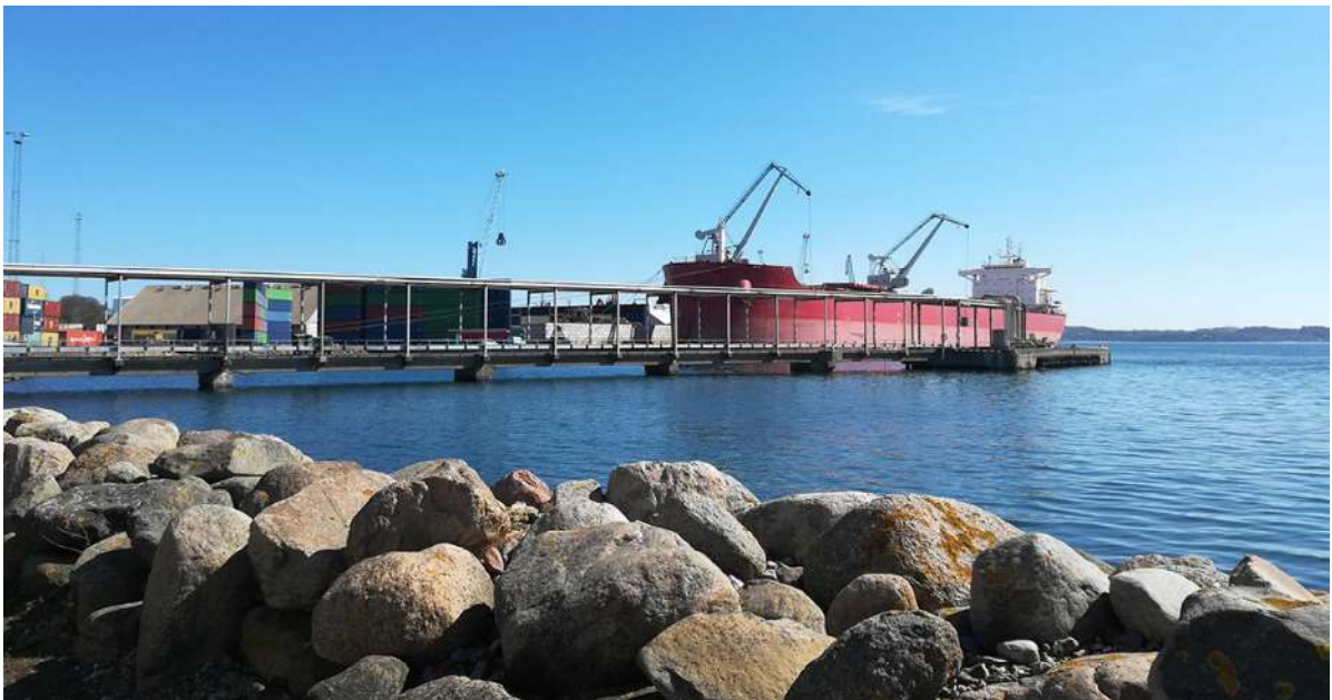
Den nuværende bro pier ved kaj 23
